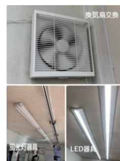
【補助金を活用した施工事例 3】 川口市換気扇交換工事及びLED照明器具交換工事。川口市商店改修事業補助金を活用して、店舗内の換気扇1台と蛍光灯器具からLED照明器具に交換しました。LED照明器具「パナソニック ウィズリモ」。リモコンの操作で明るさが変更できます。一台ずつ調整できるため、省エネ・快適さにあわせた様々なシーンに使えます。住宅用ではリモコンで明るさを変えられるものではありませんが、店舗、オフィス用が出来る。コロナ感染対策として、換気扇を交換することにより、付随のLED照明器具交換工事が補助金の対象になります！工事代金(消費税抜き)の50%が補助されました！
